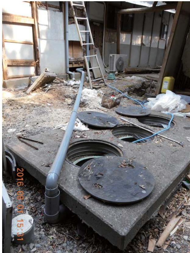
家屋から浄化槽への流入配管が破損のため、地上部に配管を通す処置
