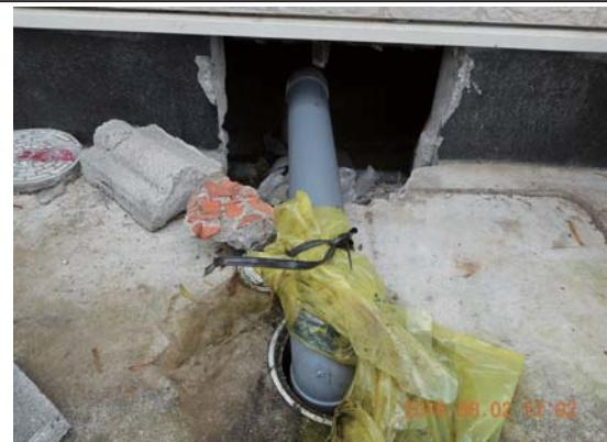
流入配管破損部をビニール等で覆うなどの処置
