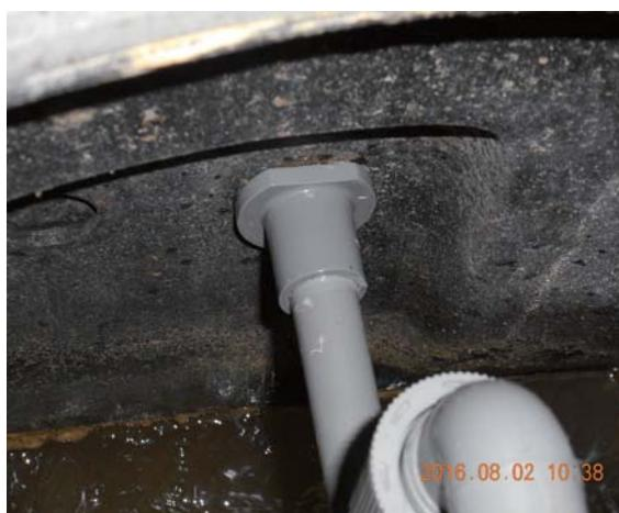
槽外空気配管と槽内空気配管連結部取替え
