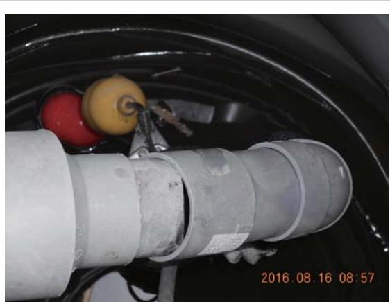
写真 5-18 移送管ずれ
