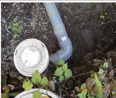
屈曲部に新しい管を設置して処置
