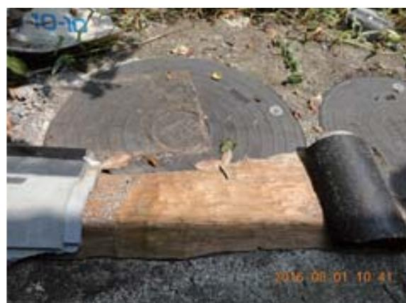
マンホール蓋破損部の処置
