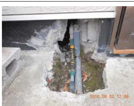
上水道管の破損処置
