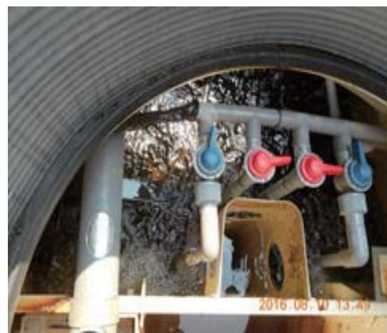
槽内空気配管切断部をビニールテープで接続
