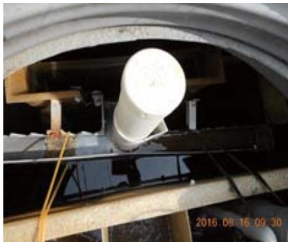
越流ぜき固定不良を紐で固定処置
