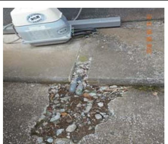
土中の空気配管を接続処置
