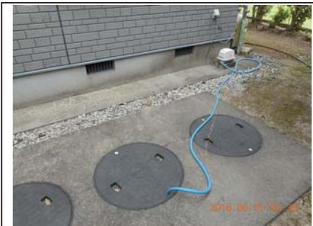
写真5-2 槽外空気配管措置済
