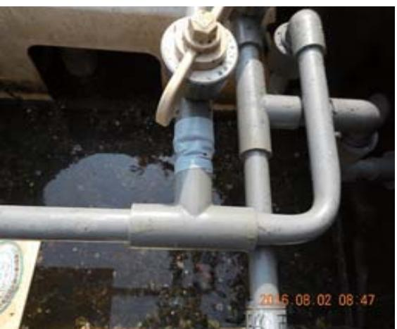
槽内空気配管切断部をビニールテープで接続
