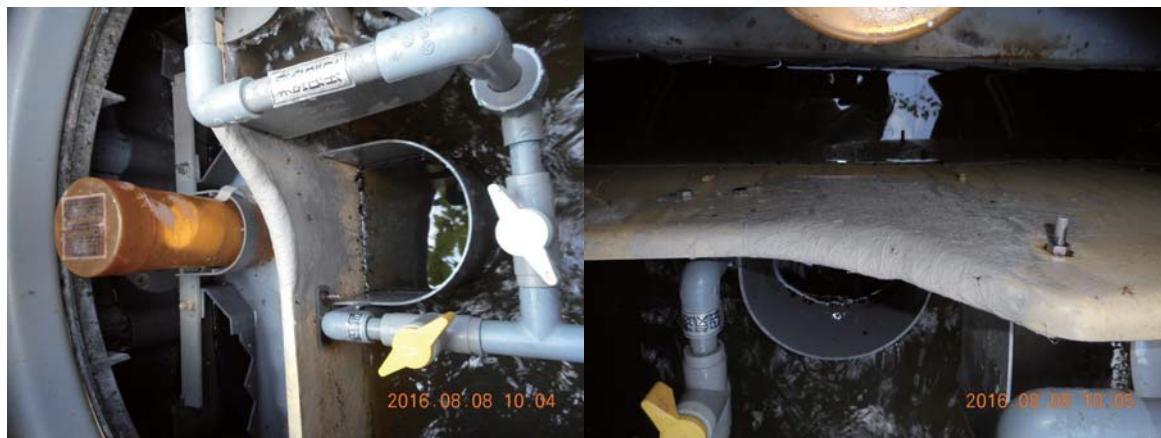
槽内ばっ気槽と沈殿槽の隔壁亀裂破損のコーティングによる処置
