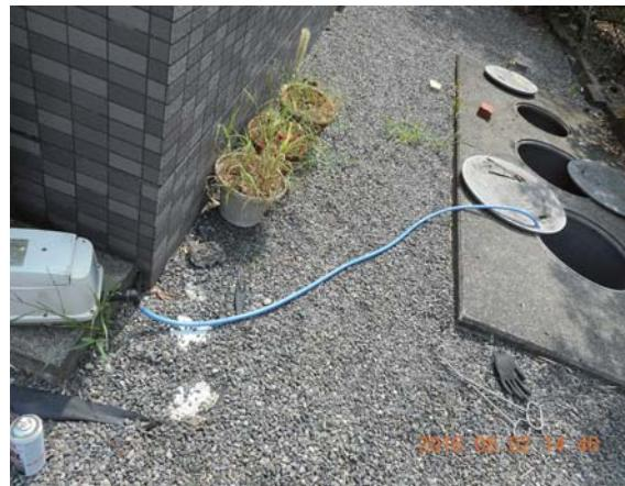
送風機から直接ホースで浄化槽内空気配管へ直結の処置
