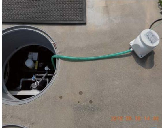
送風機から直製ホースで浄化槽内空気配管へ直結の処置
