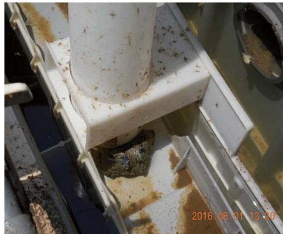
越流ぜきの傾きを石で調整処置
