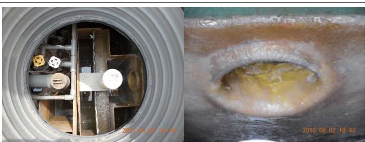
放流管接合部の破損箇所をコーティングで処置
